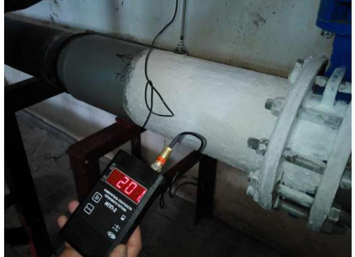
Die Industrierohre auf der rechten Seite wurden mit CERAMOR-Metall 100 beschichtet. Das hier verwendete Gerät ist ein BTU-Meter und zeigt zu jedem Zeitpunkt die durch die Rohre fließende Wärmemenge an.
